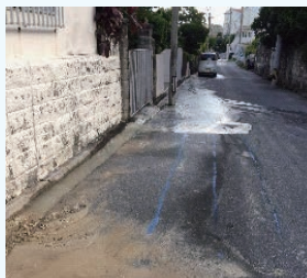
漏水箇所発見
