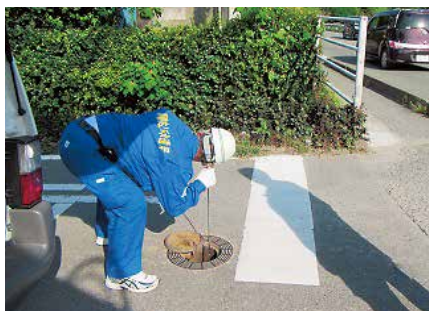
▲宇土市での漏水調査
