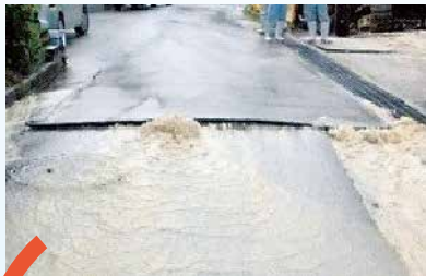
老朽化した水道管による水漏れ 更新が必要
