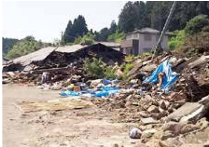
▲地震より崩落した家屋
