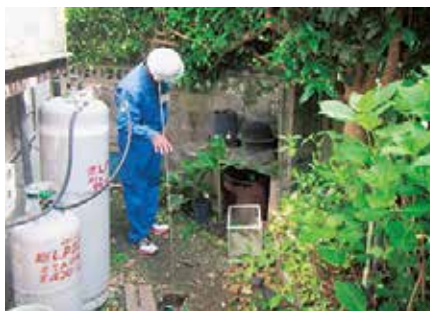
▲宇土市での漏水調査
