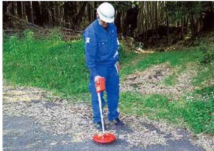
▲西原村での漏水調査
