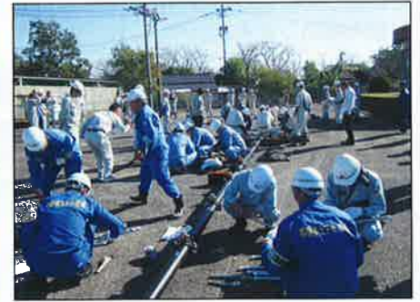
▲管路復旧訓練
