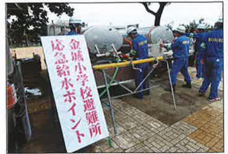
▲給水車・仮設給水栓による応急給水
