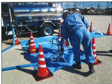
▲給水車・仮設給水栓による応急給水
