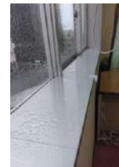
(アルミサッシからの漏水)
