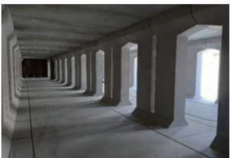
調整池内部の様子 ●貯留量約6,000m 3 (学校のプール16杯分相当)
