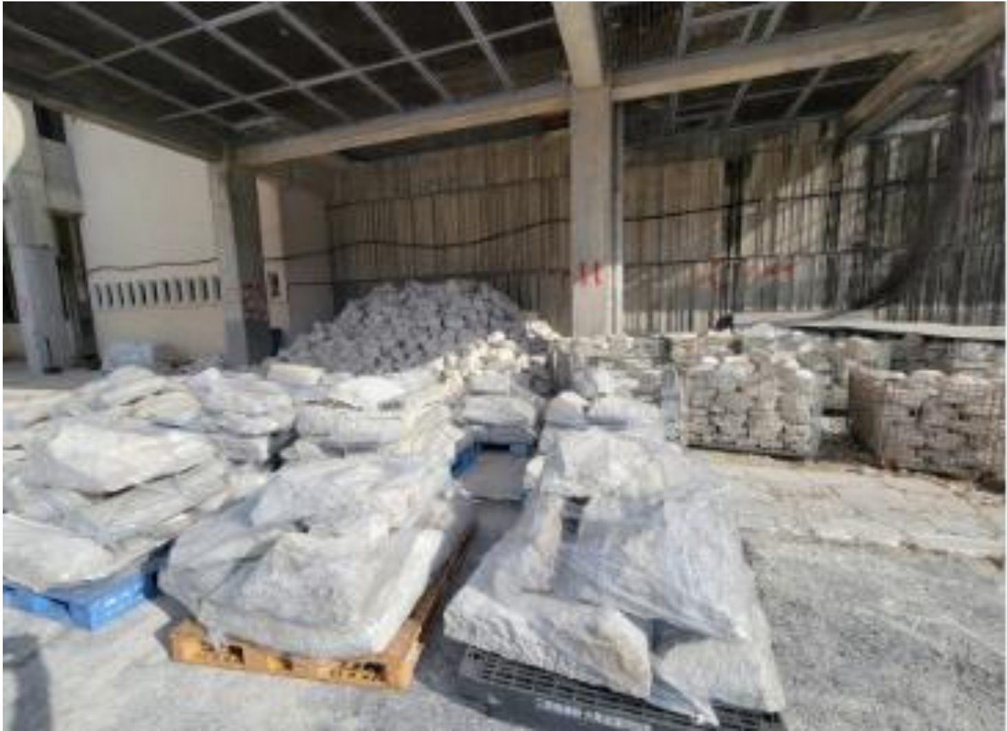
ヒンブン解体（再利用）
