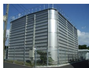
上識名配水池
