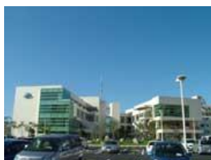
那覇市上下水道局庁舎
