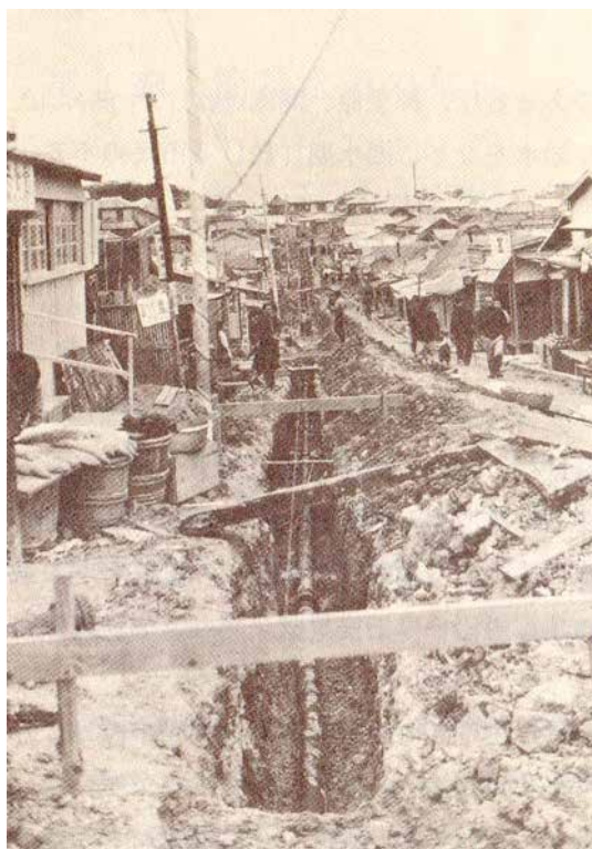
簡易水道配水管工事 (昭和26年)
