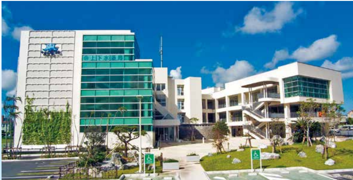
那覇市上下水道局庁舎
