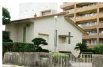
●赤嶺汚水中継ポンプ場
