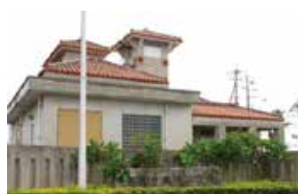
●具志汚水中継ポンプ場
