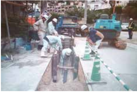
污水管工事
