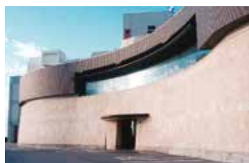
海水淡水化施設
