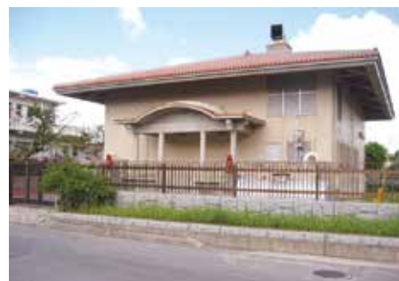
石嶺ポンプ場
