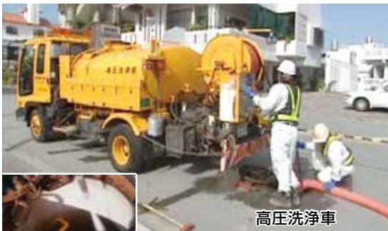
高圧洗浄車で油などで汚れた 下水道管を清掃します。
