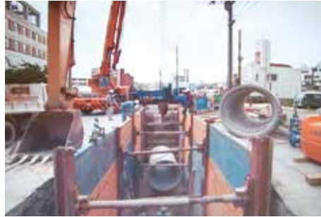
雨水管工事
