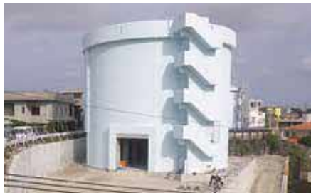
豊見城配水池
