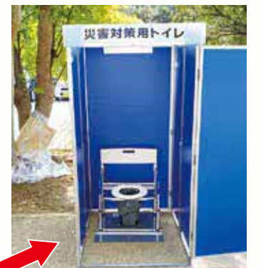
マンホールトイレ
