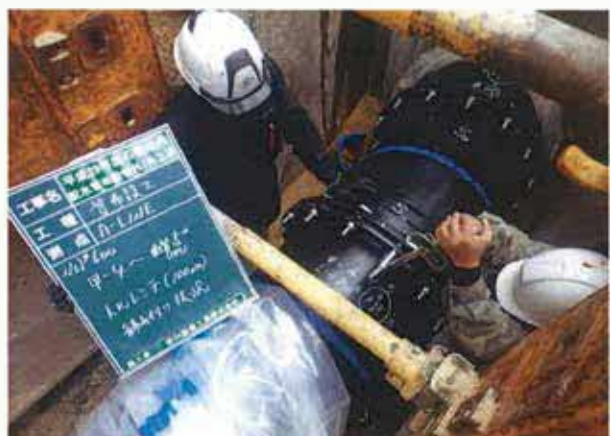
写真 - 耐震管の布設状況
