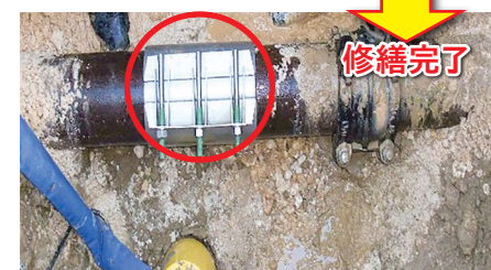
漏れて噴き出す漏水
