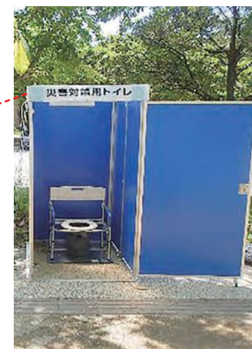
▲マンホールトイレ写真（新都心公園）
