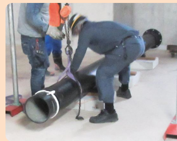
口径 250mm の配水管
