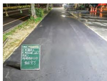
⑦ 舗装復旧(完了) 道路を元通りにして完成です。
