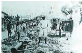
波の上一帯配水管埋設工事
