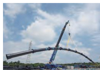
水道管の更新時は「伸縮性」・「屈曲性」・「離脱防止機能」を備えた耐震管への布設替え
