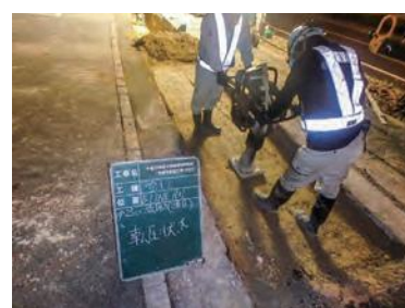
⑥ 埋戻し・締固め 道路に凸凹ができないように埋戻しします。
