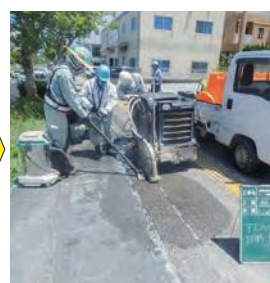
② アスファルト舗装切断 アスファルトカッターを使用します。
