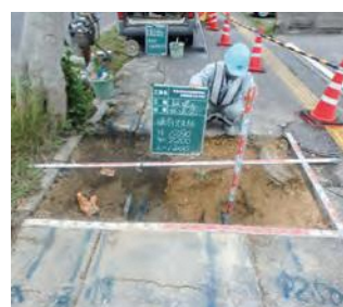
① 試掘 工事の前に他の占用物の調査をします。
