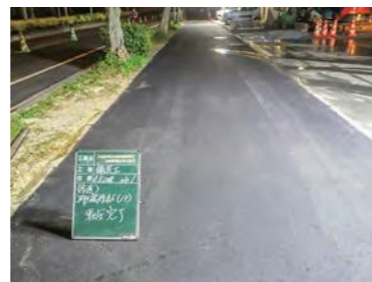
⑦ 舗装復旧(完了) 道路を元通りにして完成です。
