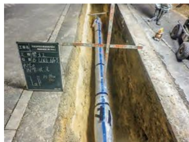
⑤ 新しい水道管布設 耐震性にも優れた新しい管を布設します。
