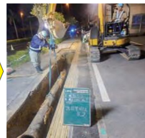
④ 既設管撤去 古い水道管を撤去します。
