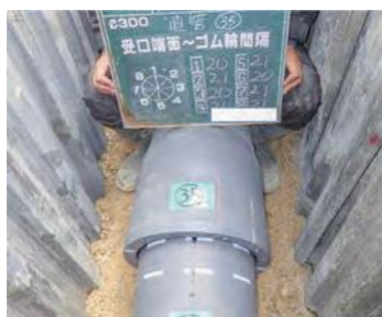
耐震管の布設状況
