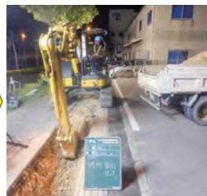
③ 工事のための掘削 掘削機械で穴を掘ります。
