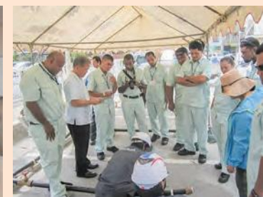
局内での配管施工実技状況
