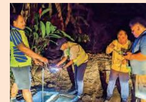
現地での夜間漏水調査指導状況
