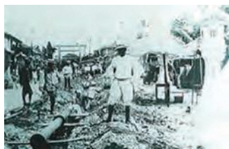
波の上一帯配水管埋設工事
