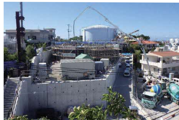
1基目施工途中
