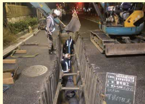
耐震管の布設状況
