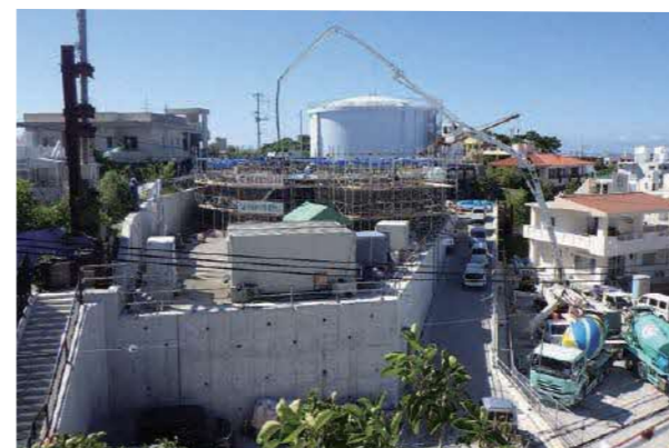
1基目施工途中
