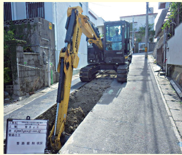
重機の掘削状況
