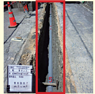
新設管の埋設状況
