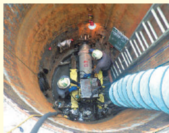
推進機稼働状況
