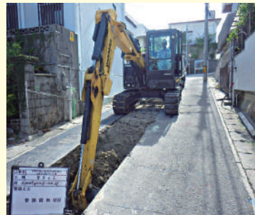
重機の掘削状況
