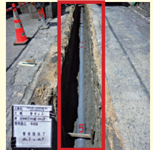
新設管の埋設状況
