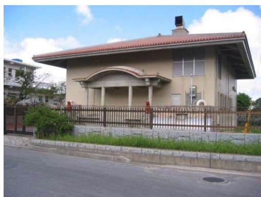
石嶺ポンプ場
