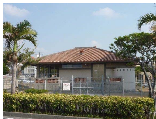
垣花ポンプ場
