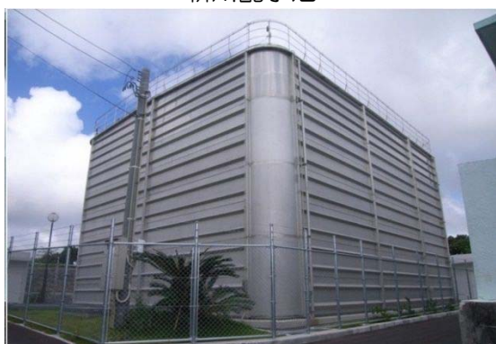
上識名配水池
