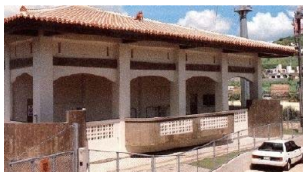
豊見城ポンプ場
