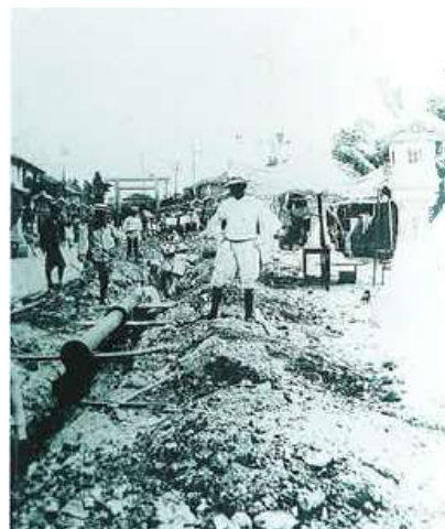
波の上一帯配水管埋設工事
