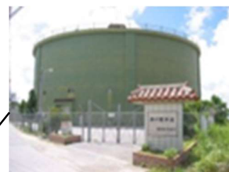
新川配水池 有効容量 8,000 m 3
