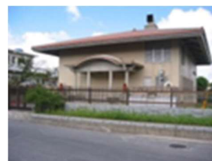
石嶺ポンプ場
