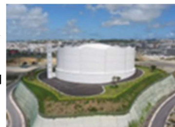
安里配水池 有効容量 13,300 m 3
