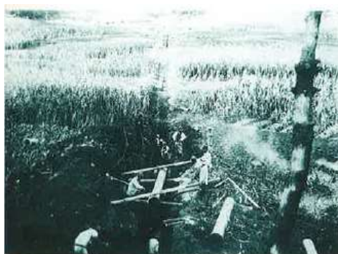
送水管 300m/m 布設風景
