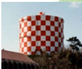
赤嶺配水池 有効容量 4,000 m 3
