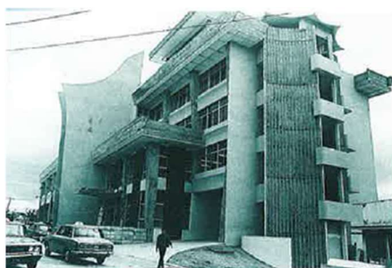
完成当時の庁舎
