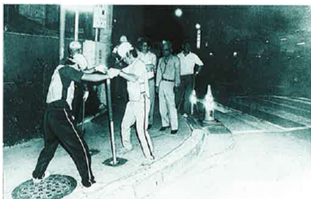
夜間の給水制限に伴うバルブ操作
