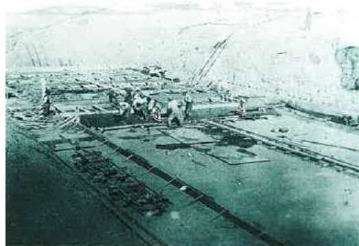
1932. 7 泊浄水場配水池建設風景
