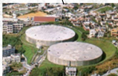
上間配水池(県)
