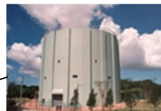
真地配水池 有効容量 3,300 m 3
