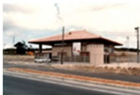
垣花ポンプ場
