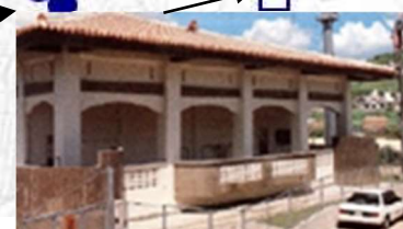
豊見城ポンプ場
