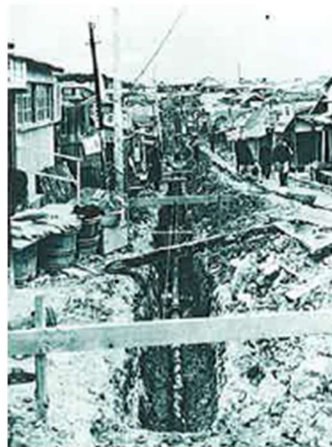
開南中央通り簡易水道配管工事
