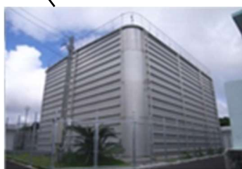
上識名配水池 有効容量 1,500 m 3
