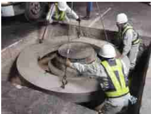
マンホール浮上対策の実施状況(H22 年 4 月)
