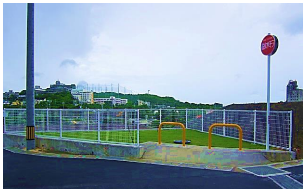
(写真1 フェンス等による区画境界)
