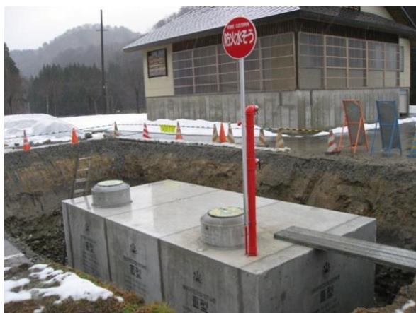
（図3 二次製品防火水槽 ）
