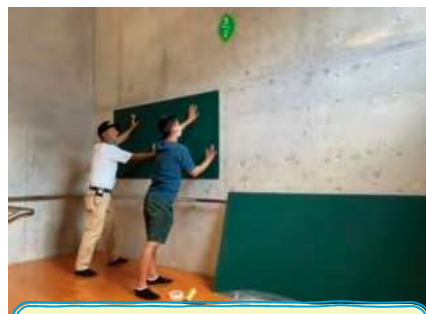
掲示板の取付け作業
