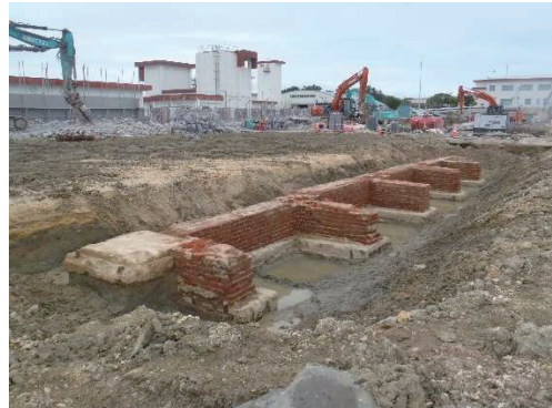
立会調査の様子
