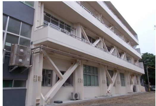
耐震改修(城岳小学校)
