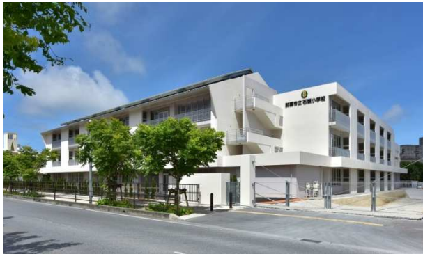
校舎改築(石嶺小学校)
