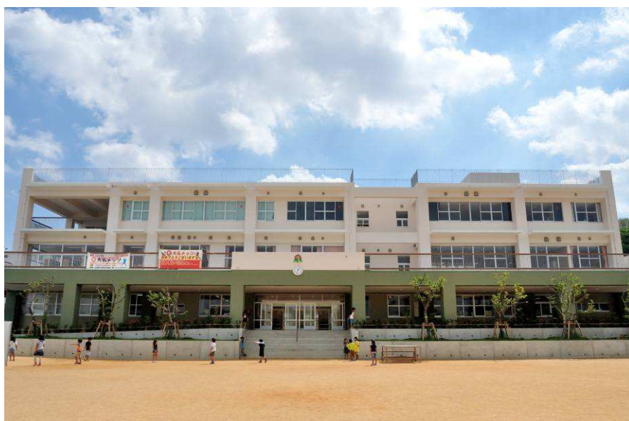
大名小学校校舎改築(平成 27 年 4 月 20 日完成)
