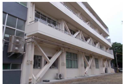
耐震改修(城岳小学校)
