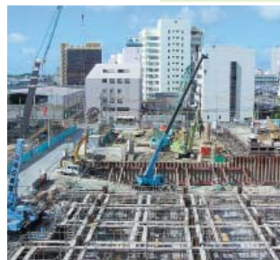
旭橋再開発事業の建設現場
