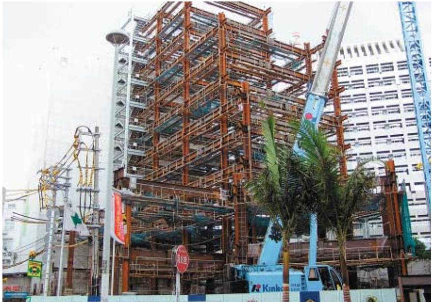
建物建築現場
