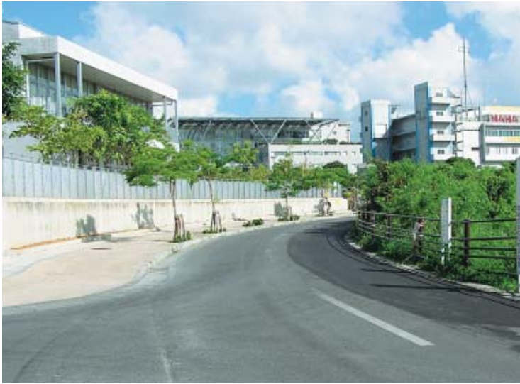
アスファルト補修された銘苅小学校通学路
