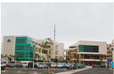
上下水道局庁舎(愛称:みずプラッサ)
