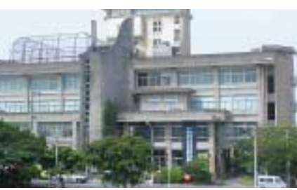
上下水道局庁舎
