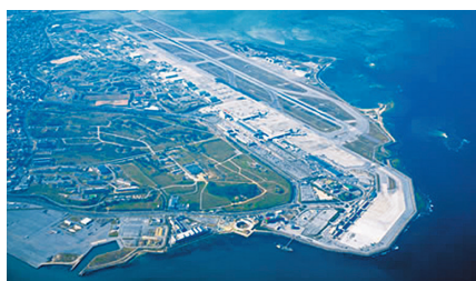
那覇空港（那覇港湾・空港整備事務所提供）
