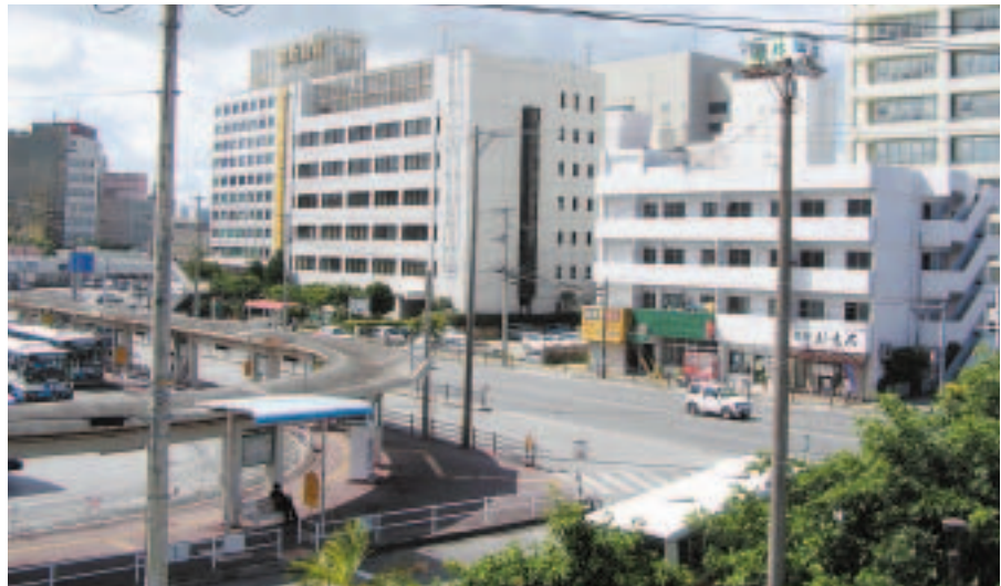
旭橋再開発事業地区
