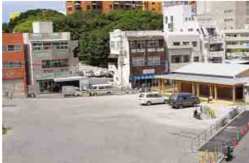
第二牧志公設市場跡地に整備中のにぎわい広場
