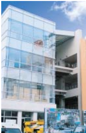
建設中のぶんかテンプス館
