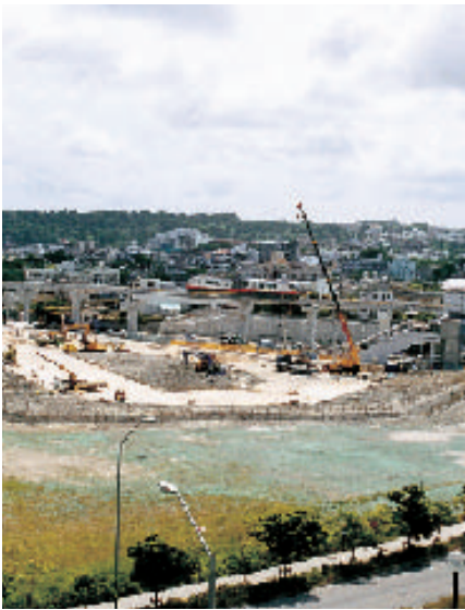
建設中のおもろまち駅前交通広場
