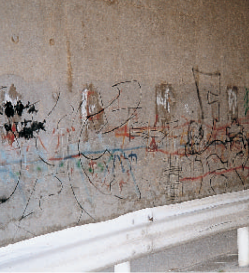
古島郵政団地入口に隣接するトンネル
