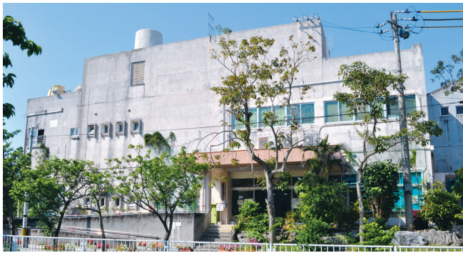
老朽化した中央公民館 (与儀公園内)
