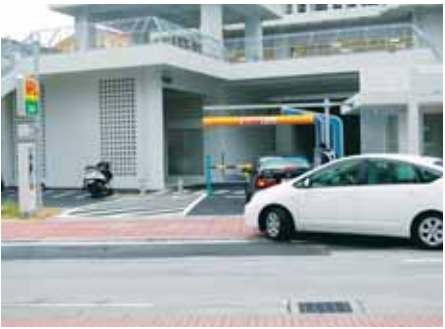
新庁舎駐車場の入口
