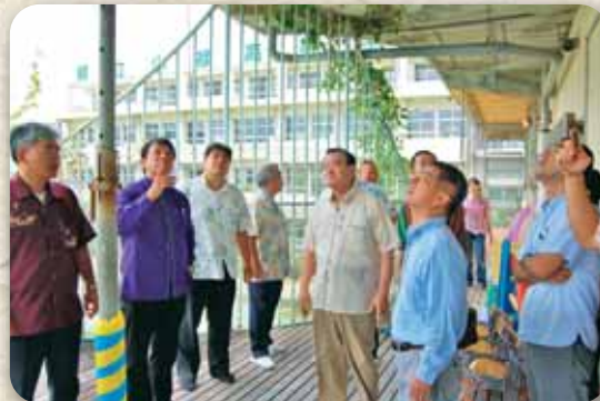
老朽化した保育園の現状を視察 (8月7日)
