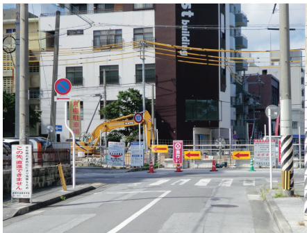
架け替え工事中の若松橋
