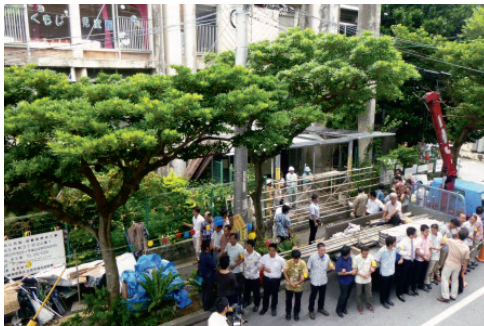
解体工事が行われる久茂地公民館
