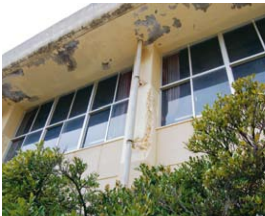
老朽化で剥離した体育館の柱(真和志小学校)
