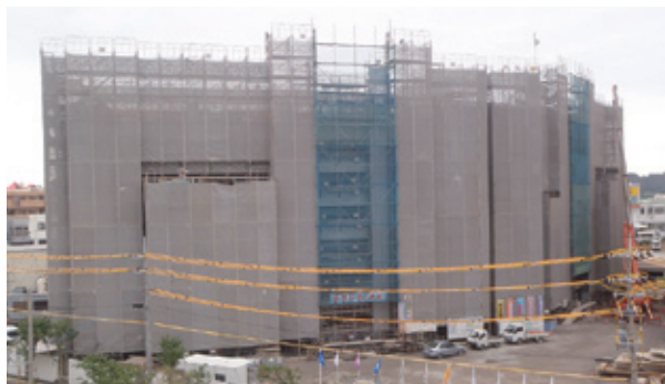
第2期建替工事中の宇栄原市営住宅
