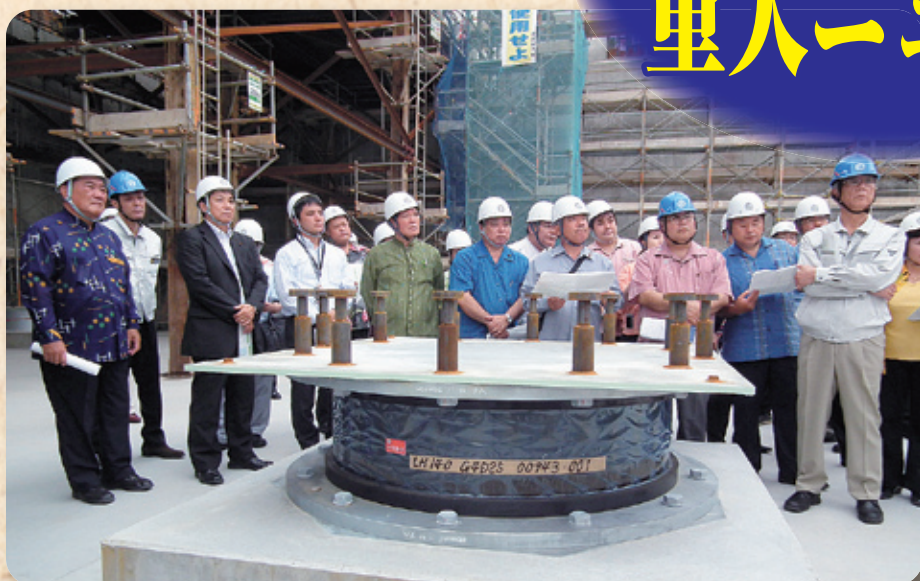
平成24年末に完成予定の那覇市新庁舎の免震層施工現場を視察(5月9日)
