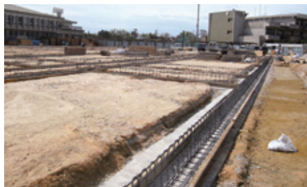
改築工事中の小緑中学校
