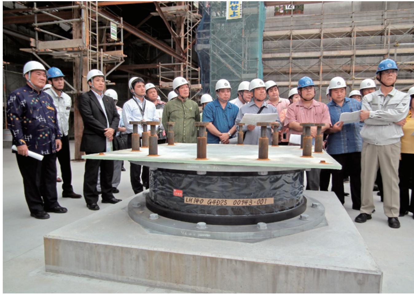
那覇市新庁舎の免震層施工現場を視察する那覇市議会議員（12面に関連記事を掲載）
