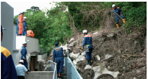
識名の土砂災害現場
