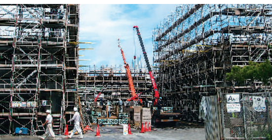
改築中の古蔵小学校
