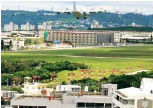
普天間基地（沖縄県基地対策室から提供）
